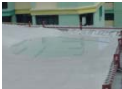
图 6 大面积膜面积水
