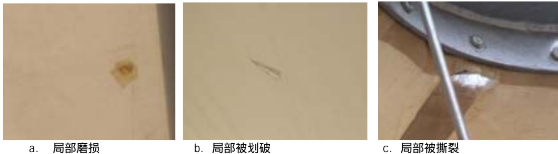
图 20 膜结构安装过程中的质量通病
