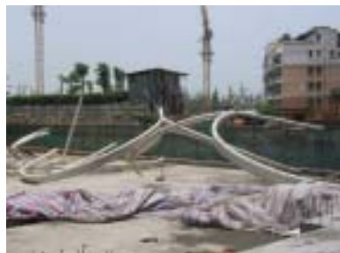
图7 因支承结构整体倾覆造成膜材撕裂
