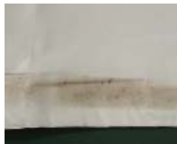
图 18 焊缝处出现脏痕
