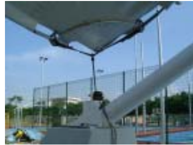
e. 临时固定
