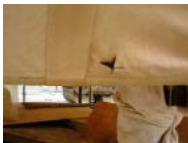
图 3 收工前在雨水管出口处开洞
