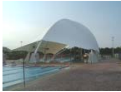
h. 完工后的情形
