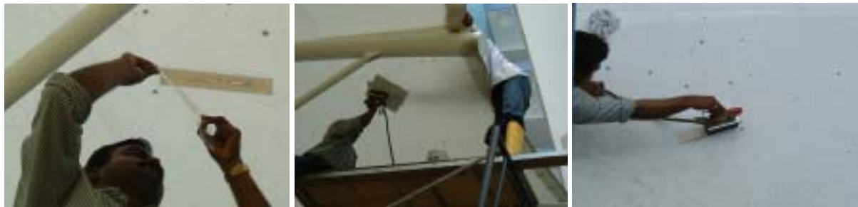
图 15 PTFE 膜材破损的现场修补
