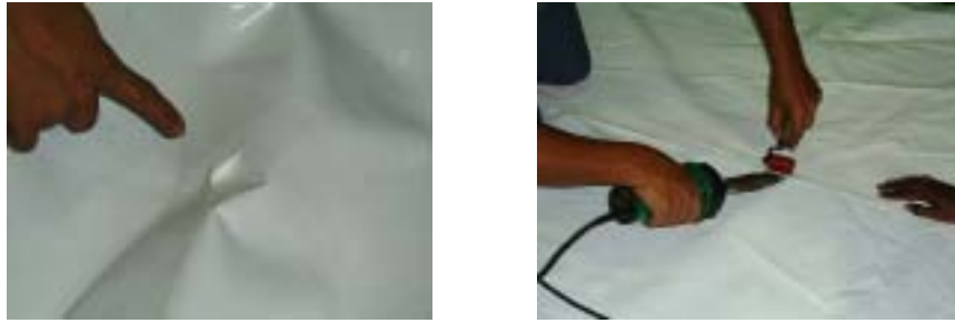
图 12 现场修补 PVC 膜材脱落焊缝
