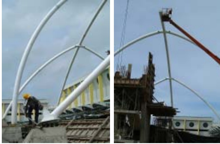
a. 支承结构吊装
