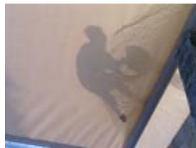
图 2 清除尚未张紧膜面的积水
