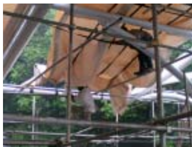
图 1 冒雨清除膜面积水
