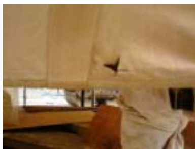
图 3 收工前在雨水管出口处开洞
