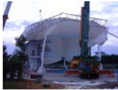
c. 两台吊车同步起吊
