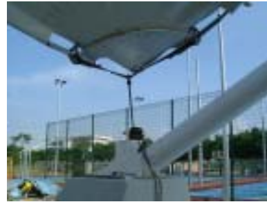
e. 临时固定
