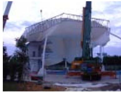
c. 两台吊车同步起吊
