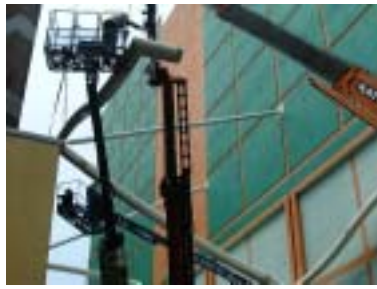
a. 安装支承结构
