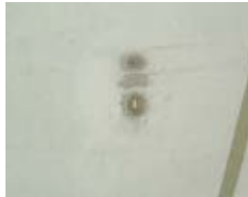
图 10 膜面小孔洞的修补
