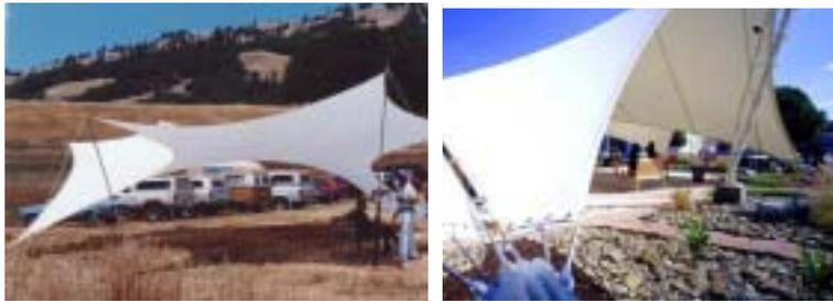
图 4 膜角直接拉到地面
