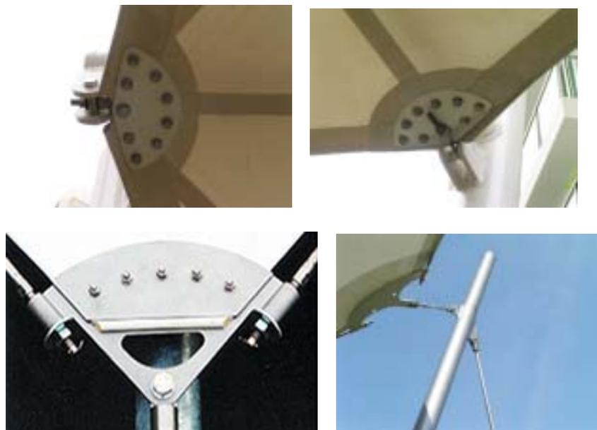
图10 张拉节点构造
