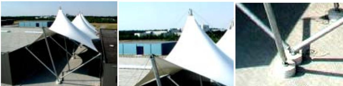
图 2 底部为铰接桅杆、顶部设拉索
