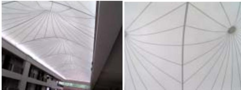
图8 单元组合时膜面热合线对齐
