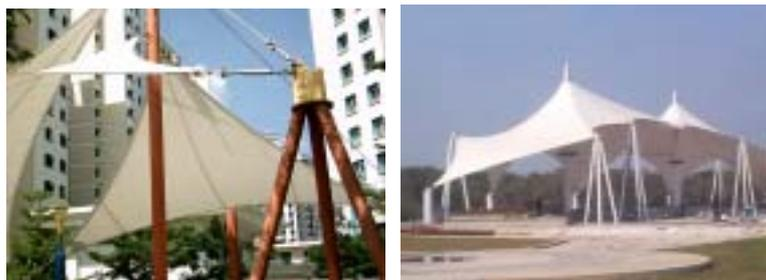
图 5 膜角由组合式边柱支承
