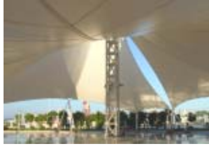
图 3 中柱为底部刚接的格构柱
