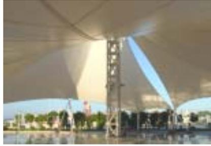
图 3 中柱为底部刚接的格构柱
