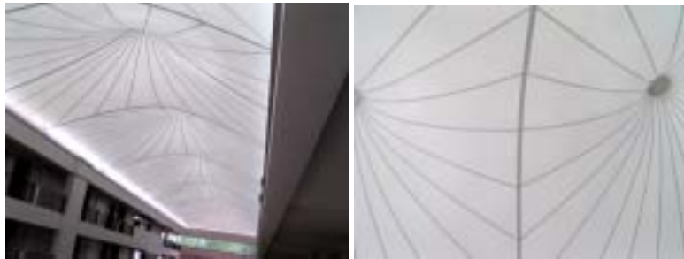
图8 单元组合时膜面热合线对齐
