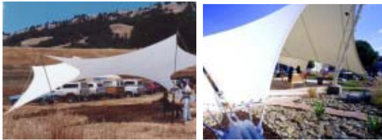
图 4 膜角直接拉到地面
