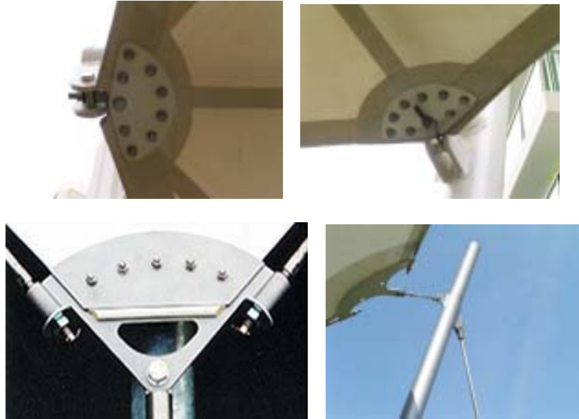
图10 张拉节点构造
