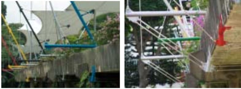
图6 利用两侧及桥底拉杆与膜面组成整体系统
