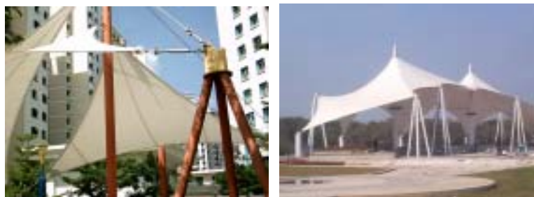
图 5 膜角由组合式边柱支承
