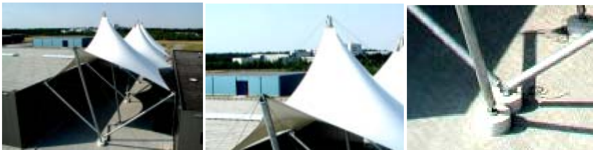
图 2 底部为铰接桅杆、顶部设拉索
