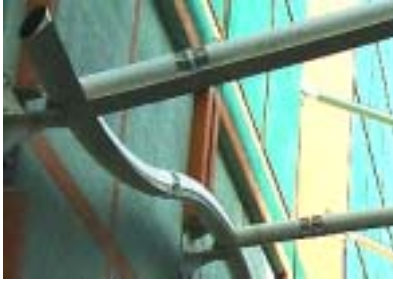
图 5 连接板角度和弧度随膜面变化
