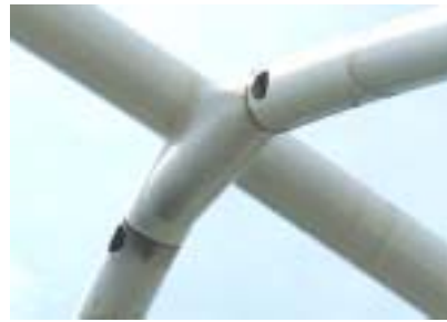
图 11 暗法兰（螺栓在钢管内）
