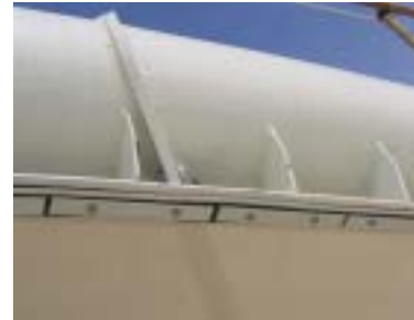
图 8 膜夹板、连接板及圆钢管节点实例
