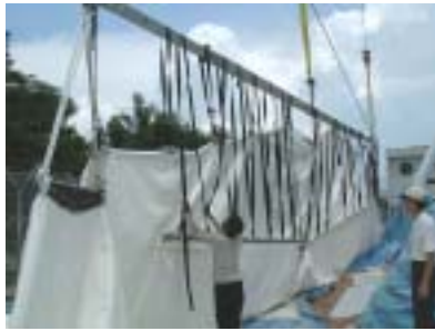
图 12 方便吊装而焊接的连续搭扣
