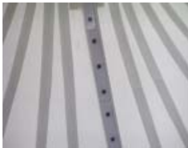
图 3 膜材的机械连接
