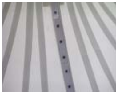
图 3 膜材的机械连接
