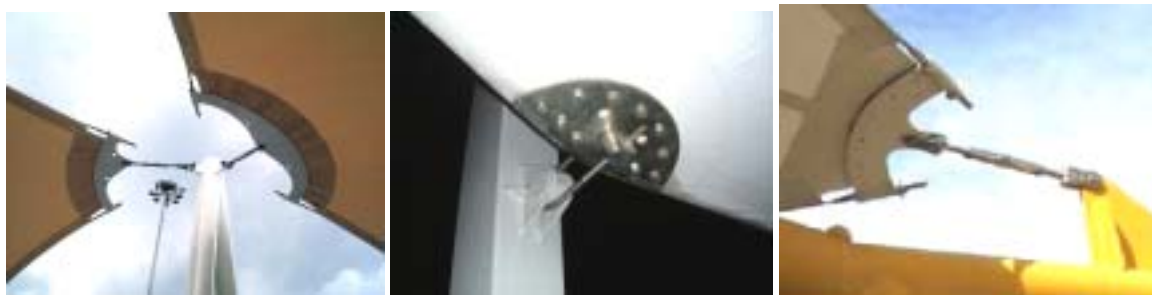
图 22 几种常用的膜节点板形式
