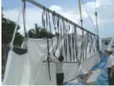
图 12 方便吊装而焊接的连续搭扣
