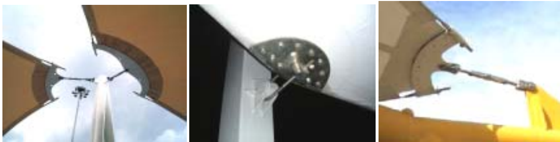
图 22 几种常用的膜节点板形式
