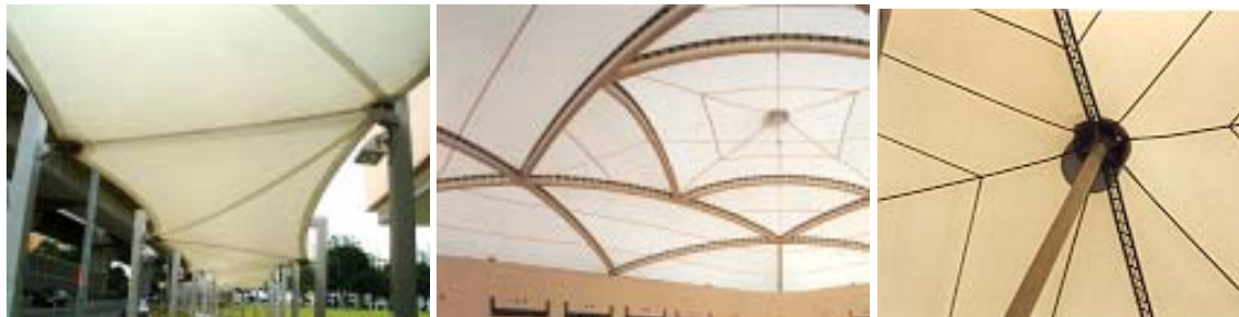
图 2 裁剪线的其他布置方式
