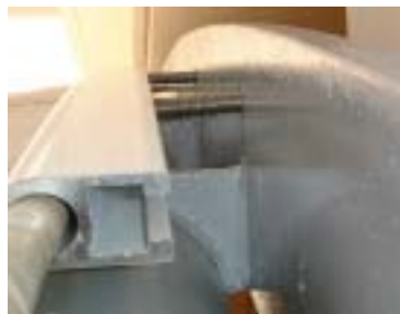
图 15 膜与支承构件绳轨连接
