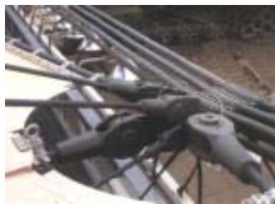
图 13 体育场内环索与径向索的连接
