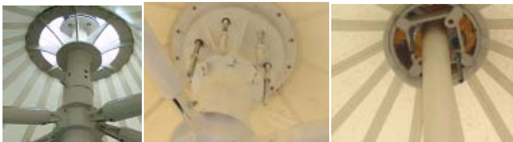
图 29 桅杆顶部可调节式节点的几种做法
