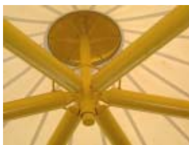
图 28 桅杆顶部固定节点构造
