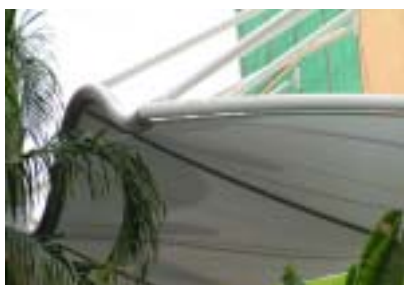
图 20 边缘刚性构件支承
