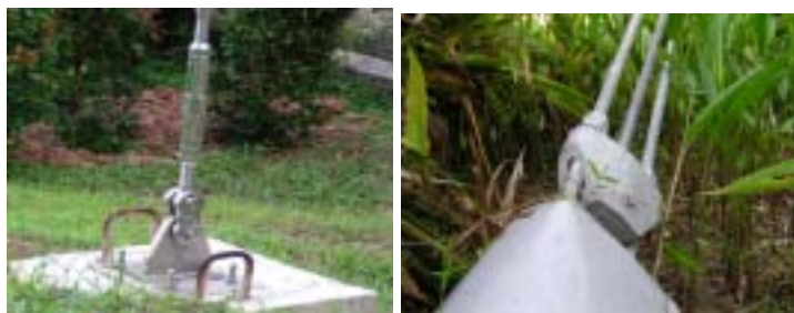
图 19 索与基础的连接
