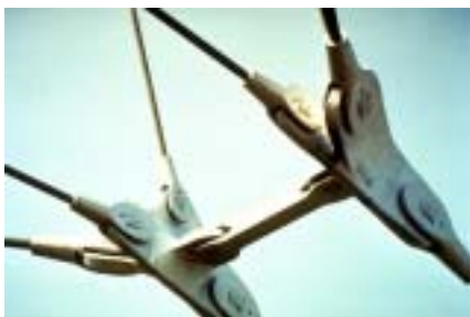
图 12 多向钢索的连接
