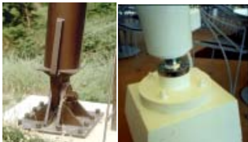
图 30 柱脚双向及三向铰接节点实例
