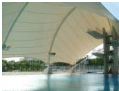
图 26 骨架支承式膜结构
