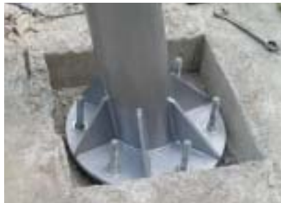
图 31 柱脚刚接节点实例
