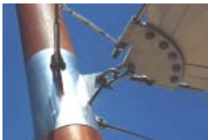
图 18 索与支承构件套箍连接
