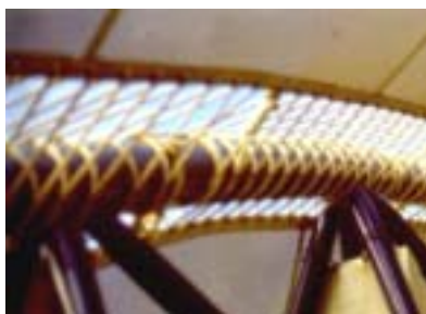
图 16 膜与支承构件束带连接
