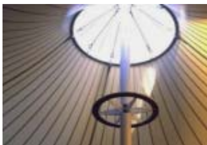
图 27 桅杆顶部浮动（悬挂）节点
