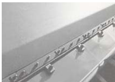
图 14 膜与支承构件夹板连接
