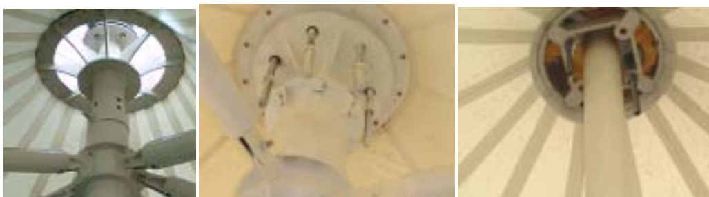
图 29 桅杆顶部可调节式节点的几种做法
