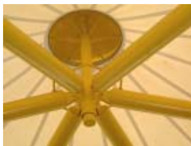
图 28 桅杆顶部固定节点构造
