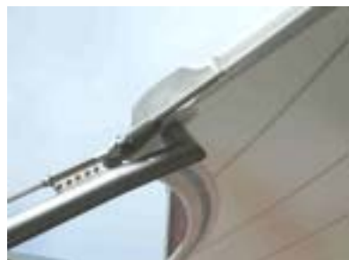
c. 在边索处焊接软管来引导雨水
