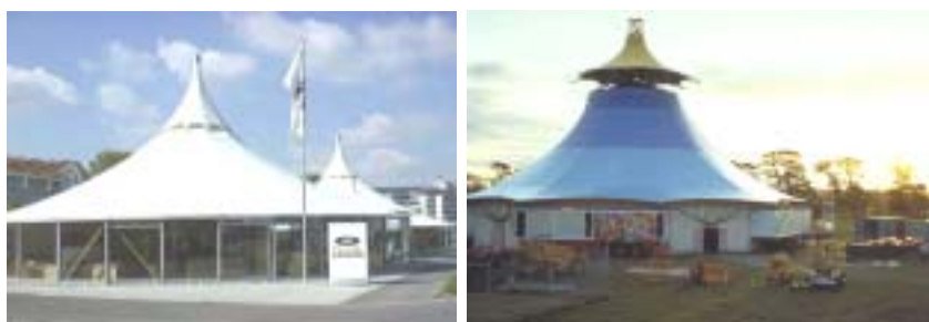
图 12 伞形膜结构的顶部通风口
