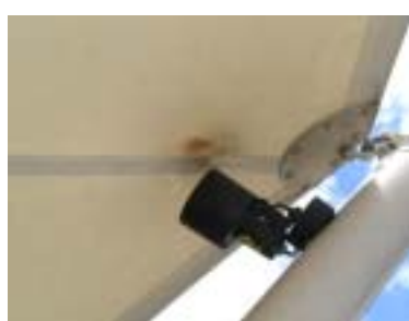
图 11 灯具与膜面过近导致膜面烤焦
