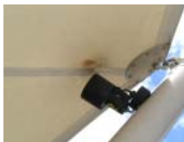
图 11 灯具与膜面过近导致膜面烤焦
