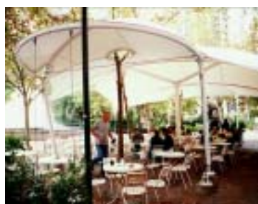
图 13 利用在膜面开洞保留树木
