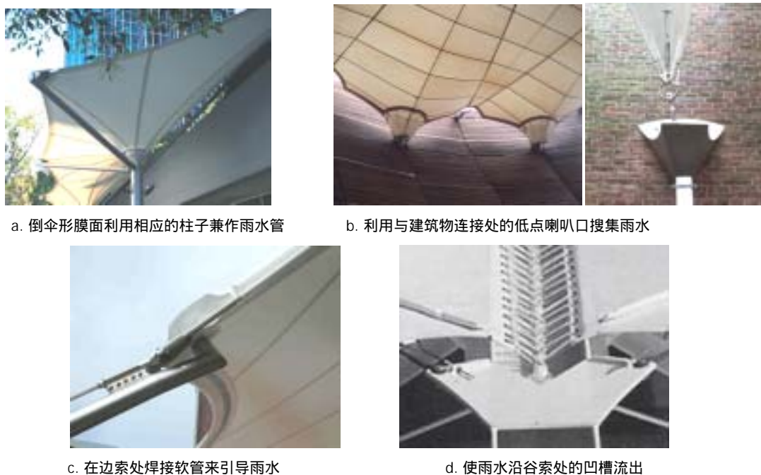
c. 在边索处焊接软管来引导雨水
