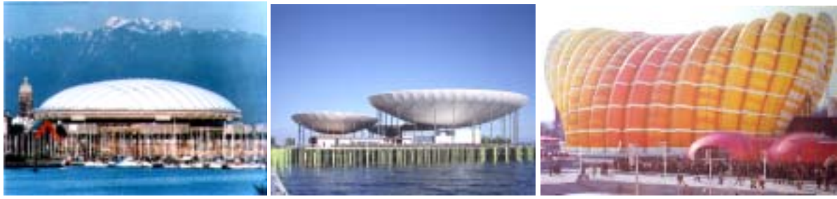
图1 充气膜结构的基本形式 a. 气承式; b. 气垫式; c. 气肋式
