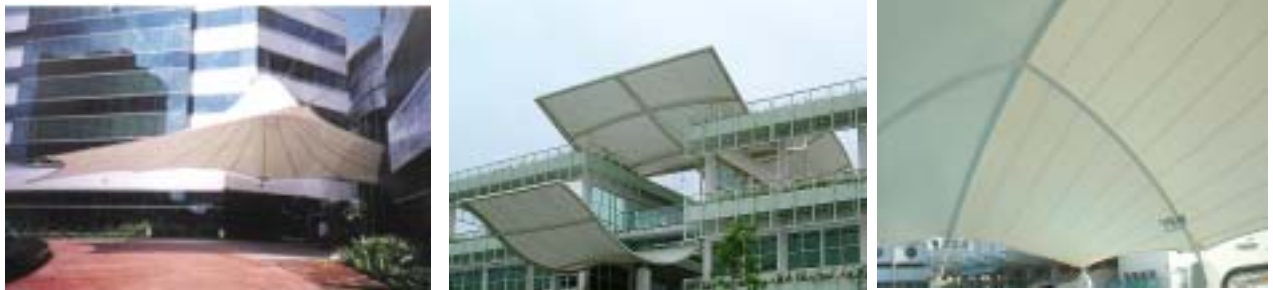
图 5 张拉膜结构的支承体系 a. 柔性支承体系 b. 刚性支承体系 c. 混合支承体系
