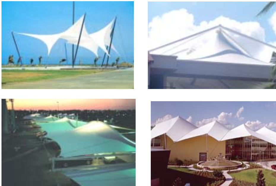
图 4 张拉膜结构的基本形式 a. 马鞍形 b. 圆锥形（伞形） c. 拱支承形 d. 脊谷式
