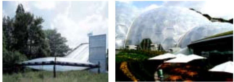
图 3 ETFE 气垫及其代表工程
