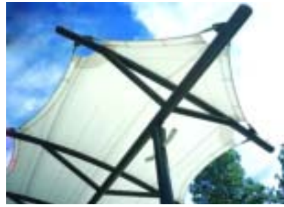
图8 用TENARA膜材建造的高透光性结构
