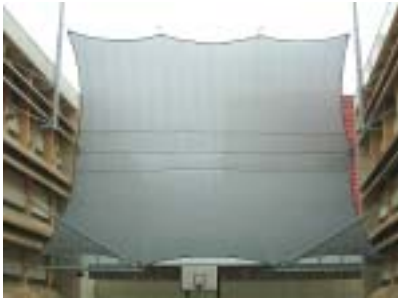
图7 用网状膜材建造的竖向视线屏蔽结构
